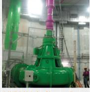
口 径:300~3300mm 吐出量:10~1500m³/min 全場程:3~20m 用 途:下水排水、汚水排水、雨水排水、農業用水等 Diameter: 300 - 3300 mm Discharge capacity: 10 - 1500 m<sup>3</sup>/min Total head: 3 – 20 m
